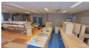
20 – Wastafelwerkplaats De wastafelmeubels maken we in eigen beheer. Daarmee besparen we op de kosten, maar bovenal kunnen we ze zo volledig op maat en geschikt voor de doelgroep en het gebruik maken.
